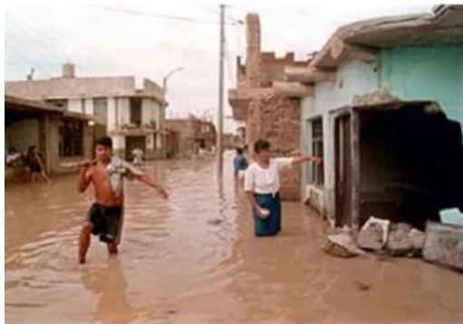
Calle de Chiclayo totalmente inundada luego de las lluvias del 14-15 de febrero 1998 y el colapso del sistema de alcantarillado de la ciudad. Se observa la abertura que abrió en una casa el torrente de agua y desague.
