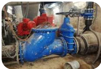
Válvulas antirretorno / compuerta volante
