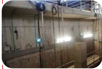
Tubo guía-izado bombas
