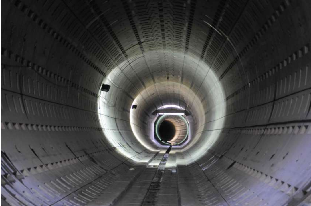
Colector de Llegada. Tunel de 7.60 mde diámetro
