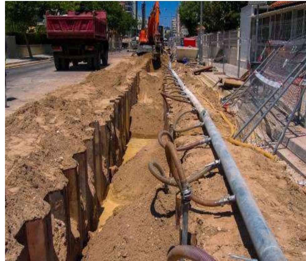
Descenso nivel freático con Well points
