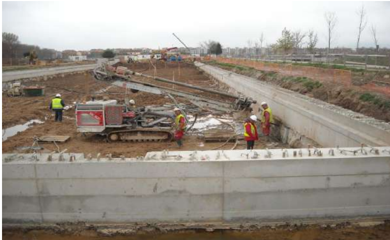
Tanque de retención en construcción
