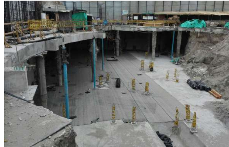
Descenso nivel freático con pozos de baja capacidad
