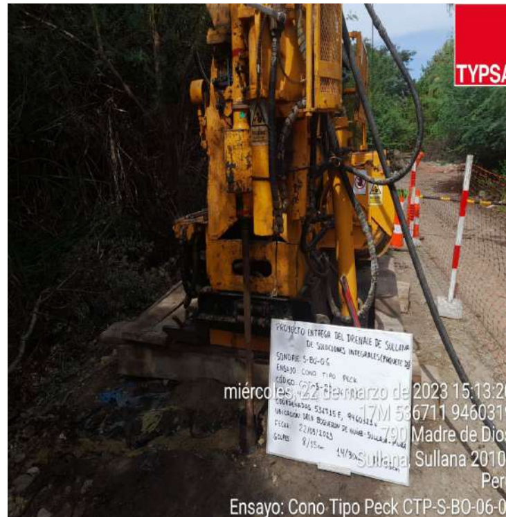
Perforación método rotativo
