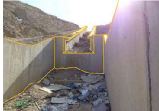
2. INICIO DEL DREN SAN MARTÍN OCCIDENTE (CAPTACIÓN, RÁPIDA Y POZA DISIPADORA)
