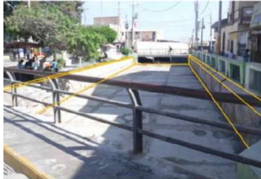
1. PUENTE ALCANTARILLA EN EL TRAMO FINAL DE CANAL VÍA ZANJÓN
