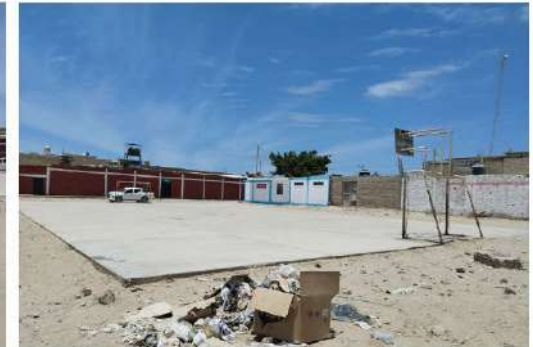
2. LOSA DE CONCRETO CON ARCOS METÁLICOS. ARROJO DE BASURA EN ALREDEDORES.
