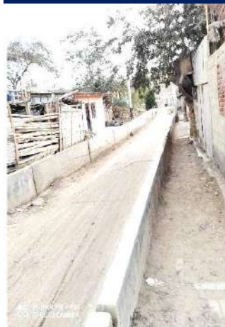
Canal Vía San Isidro
