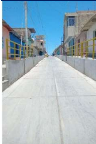
Canal Vía Jirón Arica
