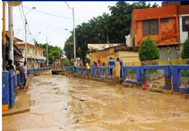
Vista Canal Zanjón (FEN)
