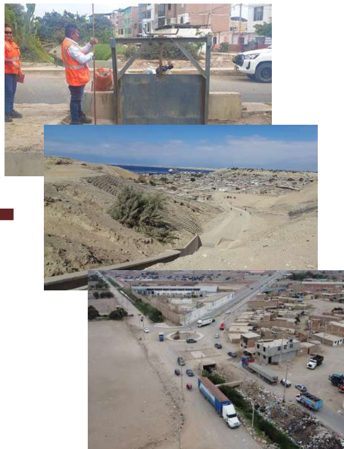
Infraestructura Hidráulica e Interferencias
